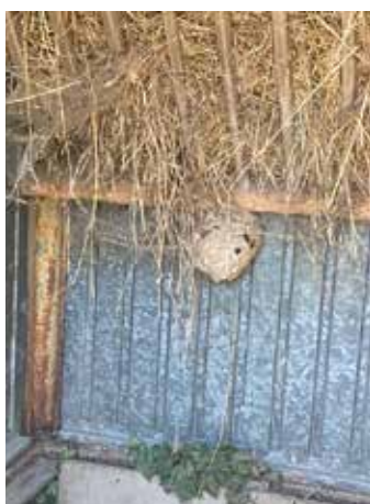
Nid sous abri chevaux
